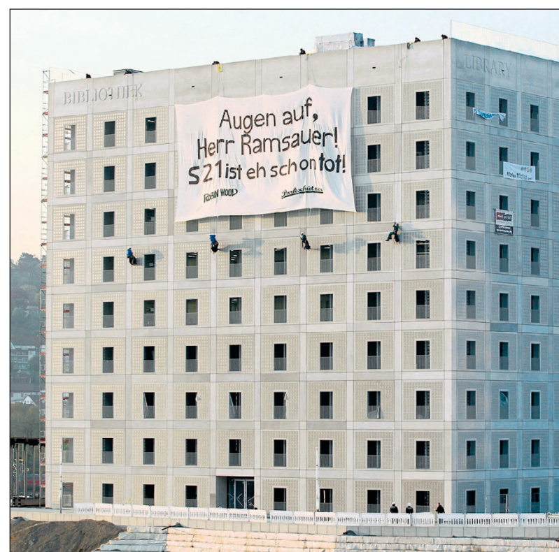
Aktivisten kletterten gestern Früh auf das Dach der in Bau befindlichen städtischen Bibliothek und entrollten an der Fassade ein Protestbanner. Foto: dpa
